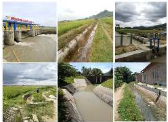
Gambar 2. Kondisi Daerah Irigasi Way Gatel
