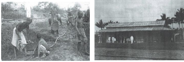
Gambar. 3.4. Pembangunan jalan kereta api (1911) dan bangunan stasiun (1913)
