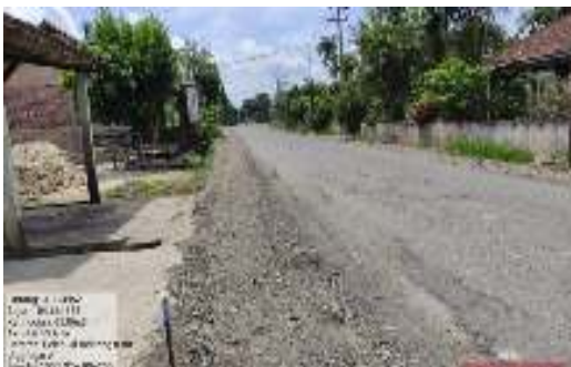
Gambar 7. Pengisian Galian Dengan Agregat A
