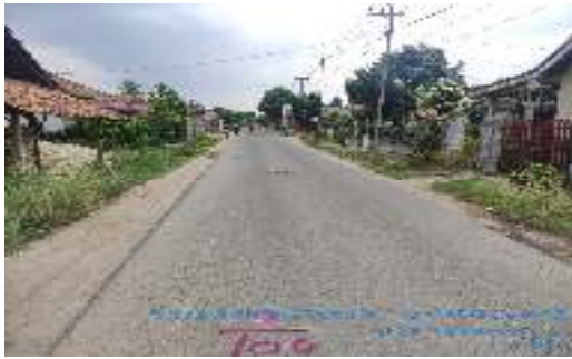
Gambar 4. Kondisi Jalan Existing
