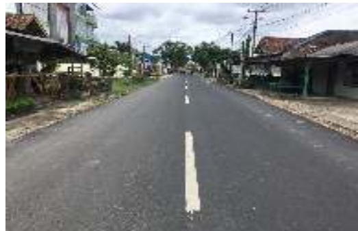
Gambar 10. Pekerjaan Lapis Permukaan AC – WC
