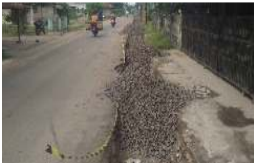
Gambar 6. Pengisian Galian Dengan Agregat B
