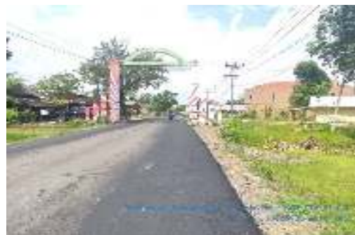
Gambar 9. Pekerjaan Lapis Permukaan AC – BASE
