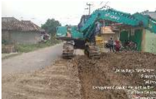
Gambar 5. Galian Perlebaran Jalan
