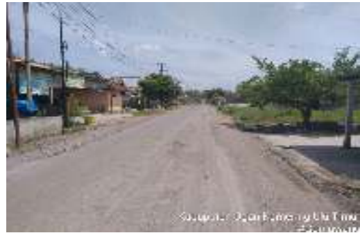
Gambar 8. Lapis Pondasi Bawah dan Lapis Pondasi Setelah Dipadatkan
